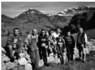
Naturschützer bauten die zerstörte Trockenmauer fachgerecht wieder auf.
