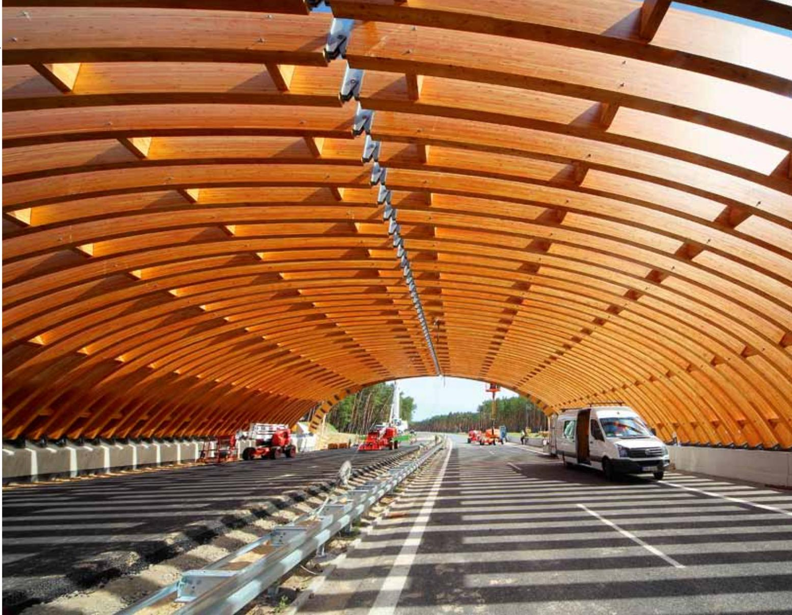
Plusieurs ponts verts en bois ont déjà été construits en Allemagne. Comme les arches préfabriquées peuvent être installées rapidement, la circulation est interrompue pour une courte durée, ce qui n'est pas le cas lors de la construction de ponts en béton.
