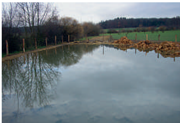
8 Der neu erstellte Weiher bei einem Grundwasseraufstoss in Wenslingen kommt ganz ohne künstliche Abdichtung aus.
