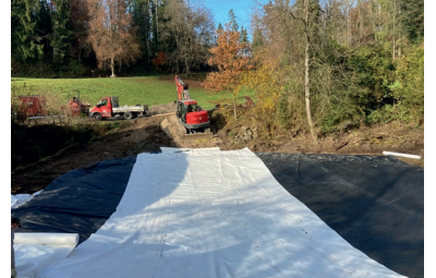
Kautschukfolie unterlegt mit Schutzvlies und über deckt mit Schutzvlies.
