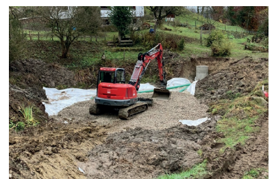
Vorbereitung des Unterbaus des Folienteichs mit Drainage und Ablassrohr für Weiherentleerung sowie drainierender und stabilisierender Kiespackung.
