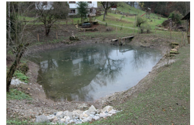
Mühleweiher 2016 nach Sanierung.
