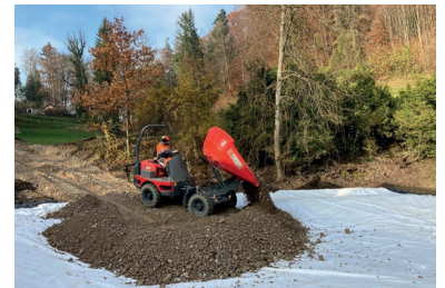
Überschüttung der Folie mit Wandkies.
