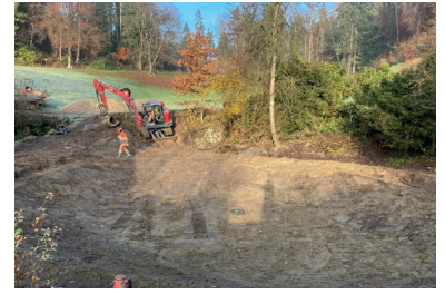
Gestaltung des Teichuntergrundes mit stabilisierendem Aushub und Flachböschungen über der Drainageschicht.
