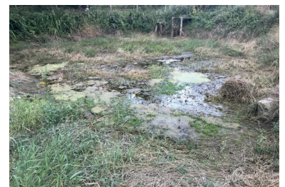
Mühleweiher 2020 mit geringem Quellzufluss und ungenügender Abdichtung.
