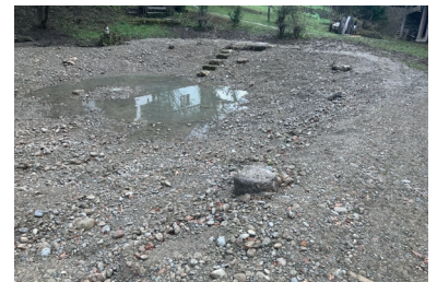
Fertig gestaltete Oberfläche des Teiches mit Steintreppe und Uferbereich. Die Böschung für die Zufahrt sowie der ufernahe Bereich wurden ebenfalls mit Wandkies belegt zur Stabilisierung des Untergrundes und als Grundlage für die Bepflanzung mit Wildblumen.
