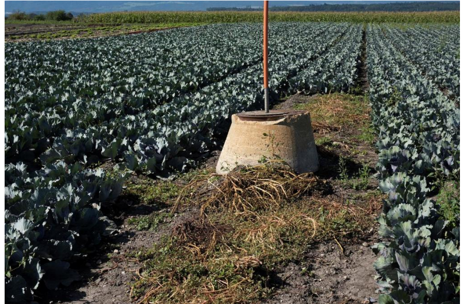
Als Folge des Torfschwunds überragt dieser einst bodenebene Entwässerungsschacht das Gemüsefeld inzwischen um rund 1 Meter. (Bild: Anja Fonseca)
